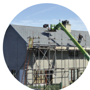
Changement de toiture
